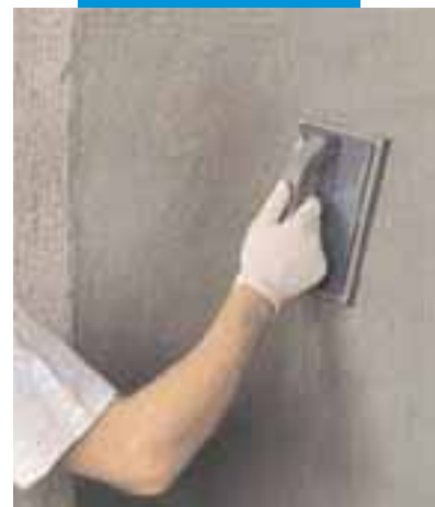
Konečná úprava povrchu Planitopu 540 houbovým hladítkem
