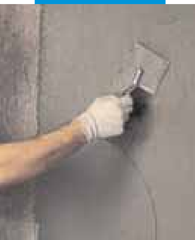
Vyhlazení povrchu Planitopu 540 ocelovým hladítkem
