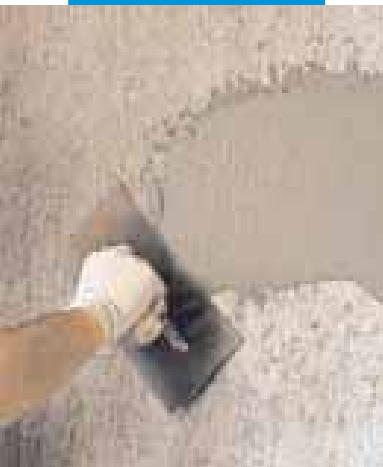
Nanášení Planitopu 540 ocelovým hladítkem
